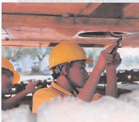
图6 2018年广西交通运输行业职业技能比赛筑路工赛项的我院选手在进行挖掘机故障测量
