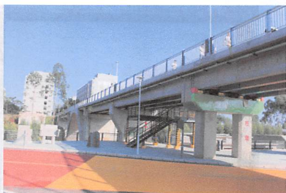
图 21 路桥教学工场教学桥梁
