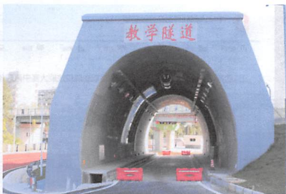
图 20 路桥教学工场教学隧道
